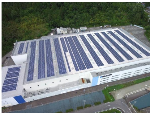
(屋上全面に太陽光パネルを設置)
